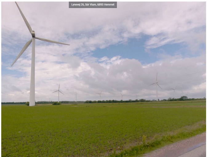
Et udsnit af de eksisterende møller, hvor der går en 60 kV højspændingsledning igennem området.
