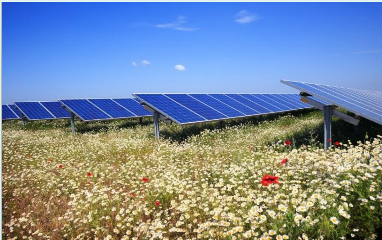
Figur 3: Eksempel på bunddække under og imellem solcellepaneler.
